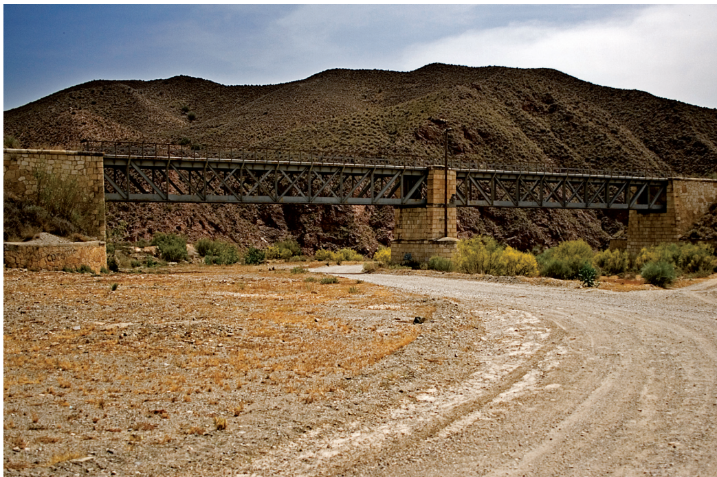
Puente del ferrocarril sobre la Rambla de Almajalejo.
