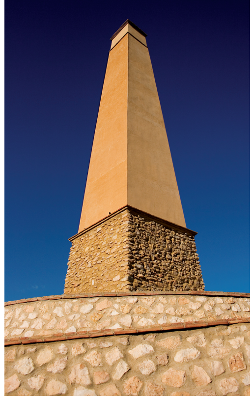
Chimenea Fundición San Ramón.
