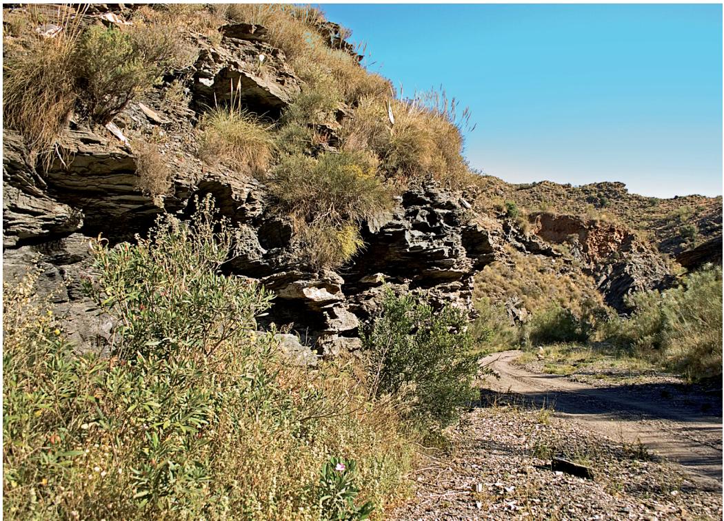
Socavamiento basal de la rambla.
