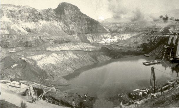
Herrerías. Las Rozas inundadas.
