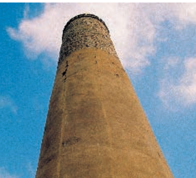
Chimenea de fundición de Las Herrerías.
